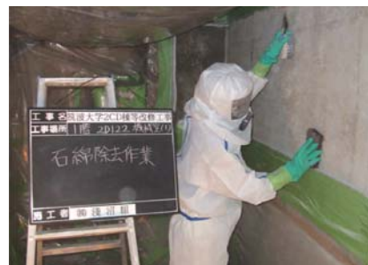
アスベスト除去作業
