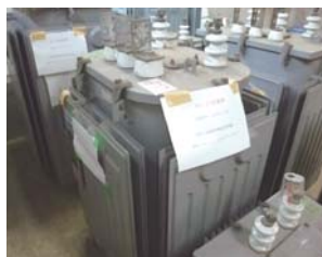
微量PCB含有廃棄トランスの保管
