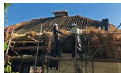
屋根葺き替え作業の様子
