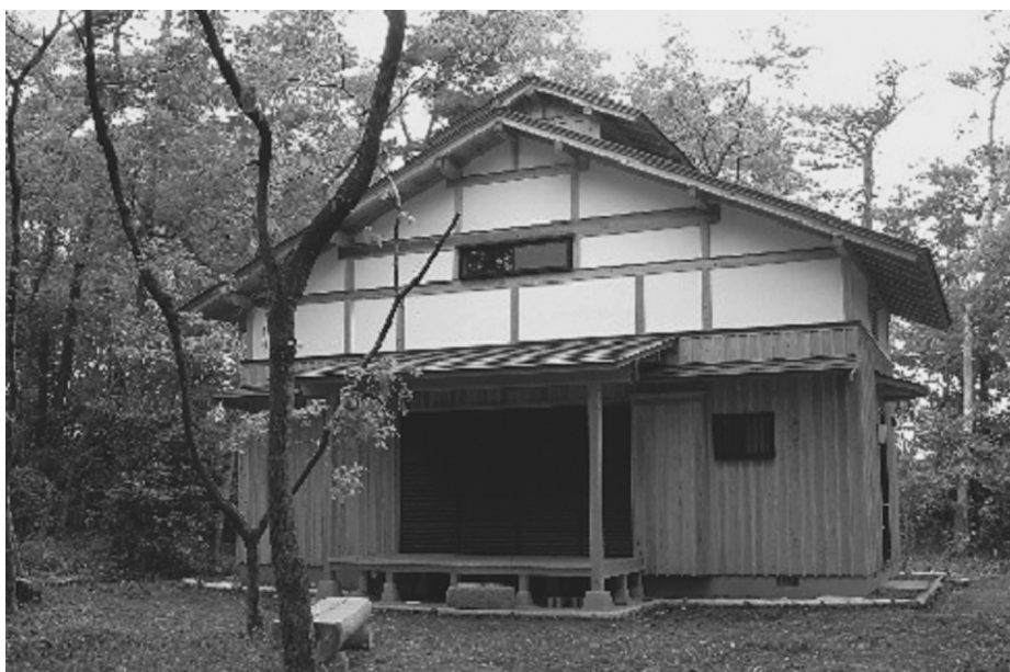
【野性の森野外活動実習管理棟】 全景
