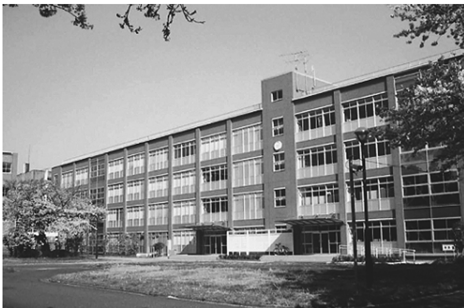
【附属聾学校高等部校舎改修】 全景
