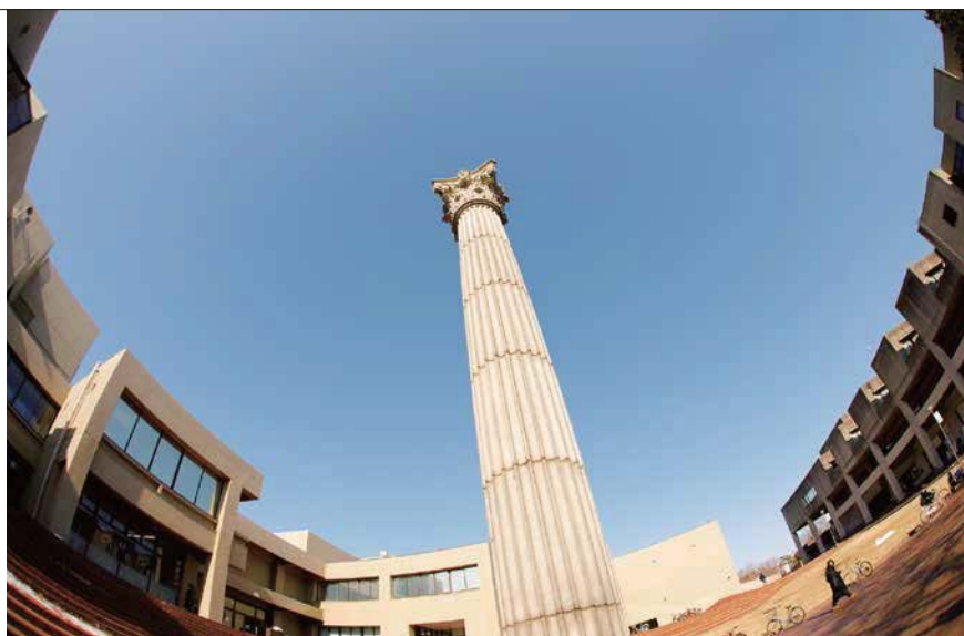
半円柱の壁飾りを2つあわせて、1本の独立柱にしている。直径1m 高さ10m 重さ約1t 御影石
