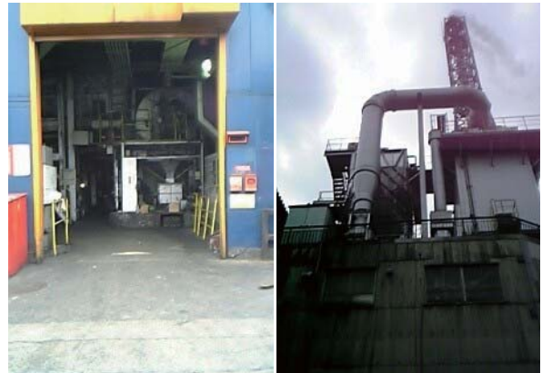
有機系廃液の処理委託先の焼却炉
