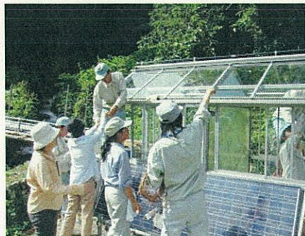
第13図:温度計設置中の光触媒ガラス温室
