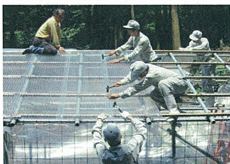
第 34 図: 温室屋根の張替え
