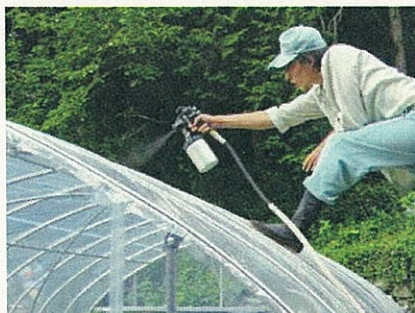
第23図:温室への \text{TiO}_2 の塗布
