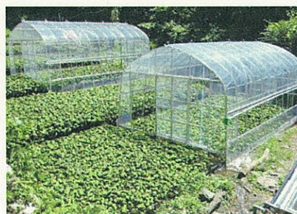
第22図:建設した普及型光触媒温室
