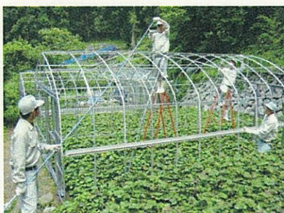
第21図:普及型光触媒温室の組立
