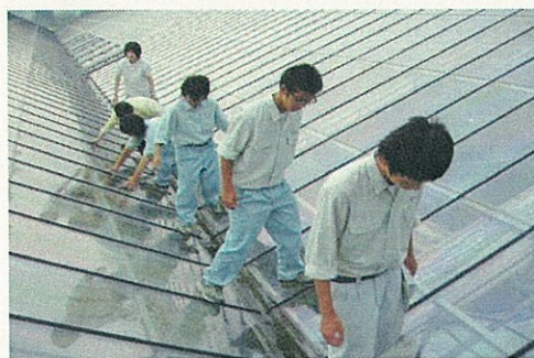
第 37 図:大型ガラス温室の屋根での散水確認
