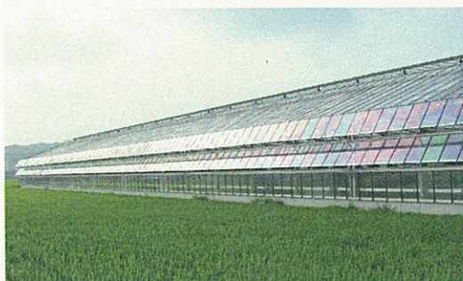
第 36 図:光触媒を塗布した 3,000m 2 の温室
