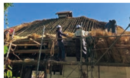
屋根葺き替え作業の様子
