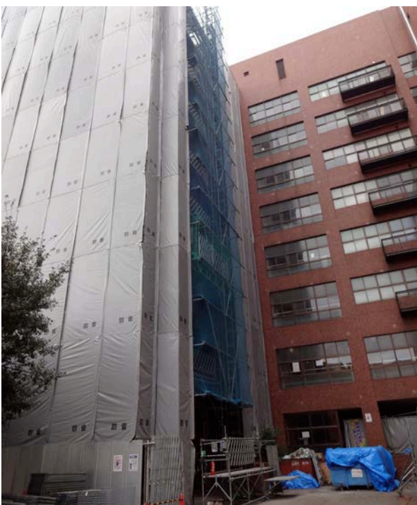
耐震工事が行われている人文・社会学系棟
