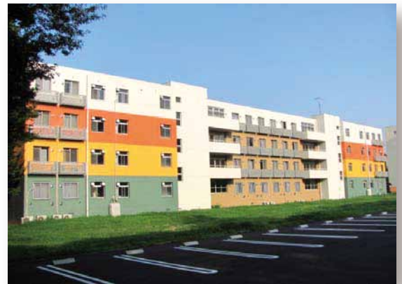
改修後の平砂学生宿舎
