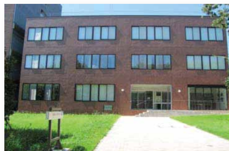
「環境防災学」講座の寄附による環境防災研究棟
