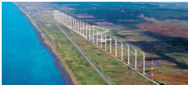
図 2 : 発電用風車の設置例
