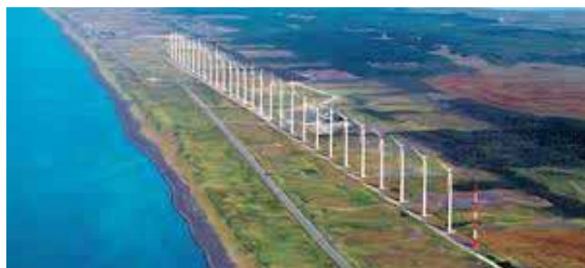
図2：発電用風車の設置例
