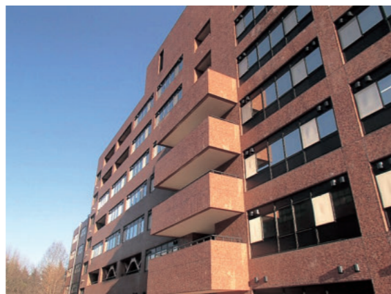
人文社会学系棟複層ガラス（二重）窓の設置
