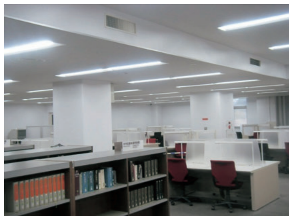
中央図書館照明改修によるLED照明の設置
