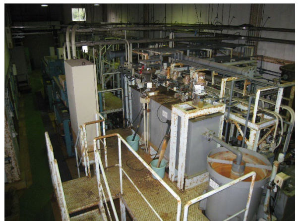
筑波大学無機廃液処理施設 上：処理施設外観 下：処理施設内部（鉄粉処理槽）
